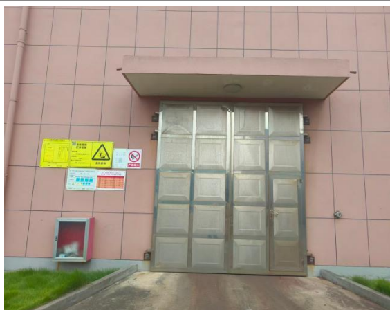
危废暂存库外部
